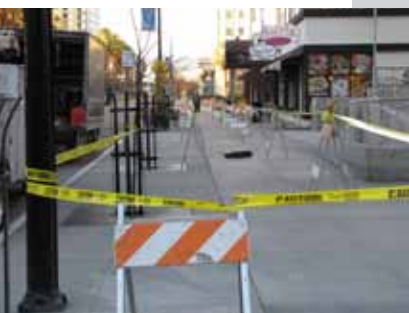
No longer compliant per 6F.74
